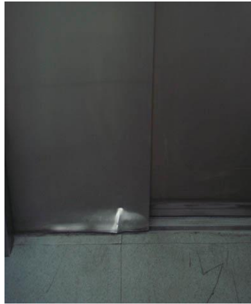
Le coin du monte-charge dans le hall d'entrée : des stigmates sur les murs et le revêtement au sol, une porte d'ascenseur abîmée
