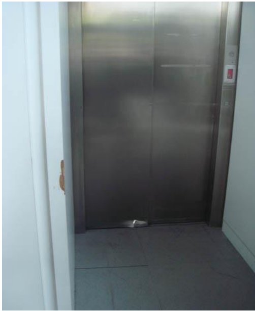
Le coin du monte-charge dans le hall d'entrée : des stigmates sur les murs et le revêtement au sol, une porte d'ascenseur abîmée
